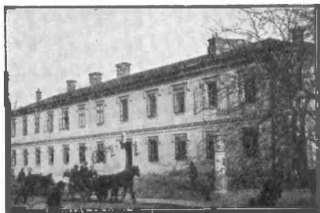
Adóhivatal és pénzügyőrség épülete
