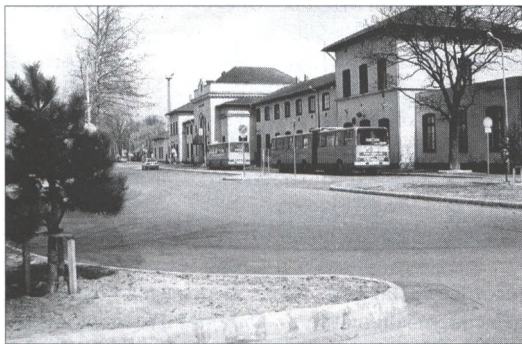
A kilencvenes évekre külsejében megújult vasútállomás épülete Fotó: Erdei
