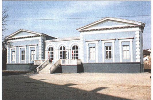
A felújított Kiskastély Fotó: Erdei
