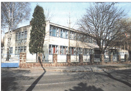
Körösi Csoma Sándor Általános Iskola épülete Fotó: Erdei
