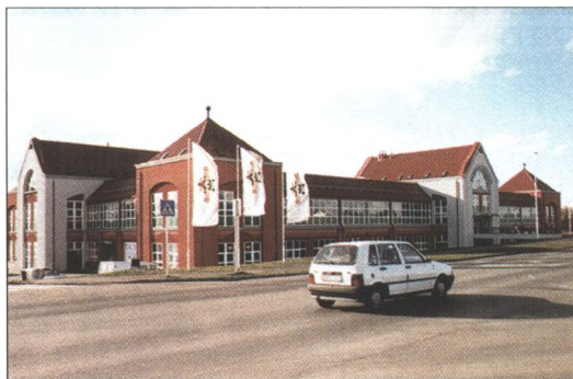
Az 1997 decemberében átadott Vásárcsarnok Fotó: Erdei
