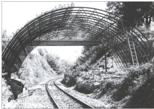
Készül a híd új fémszerkezete (1995)
