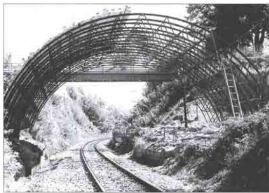
Készül a híd új fémszerkezete (1995)
