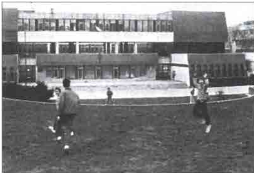
A Péterfy Sándor Általános Iskola 1977-ben átadott épülete Fotó: Erdei
