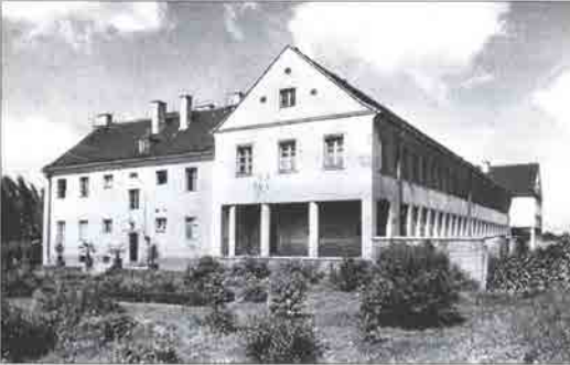
A Felsőfokú Mezőgazdasági Technikum épülete az 1960-as években (Sz. T.)
