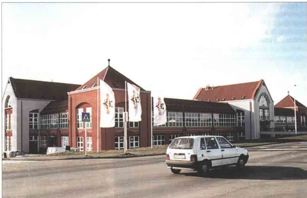
A Vásárcsarnok kivitelezéséért a cég 1998 decemberében Építőipari Mesterdíjat kapott
