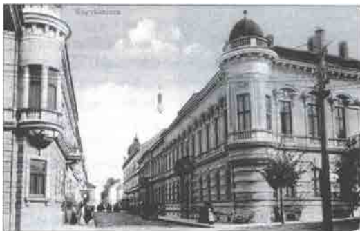
Az utca fölött átívelő vezetékeken lógtak a közvilágítást biztosító lámpák (G. R. O.)
